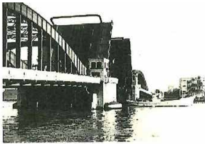
開く勝鬃橋 昭和のレガシー
