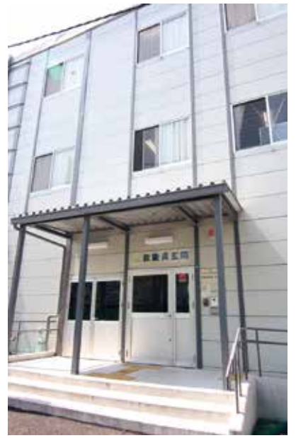
仮設校舎の教職員玄関
