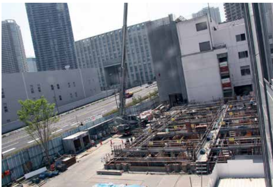
改築のため取り壊された実習棟の新たな基礎工事
