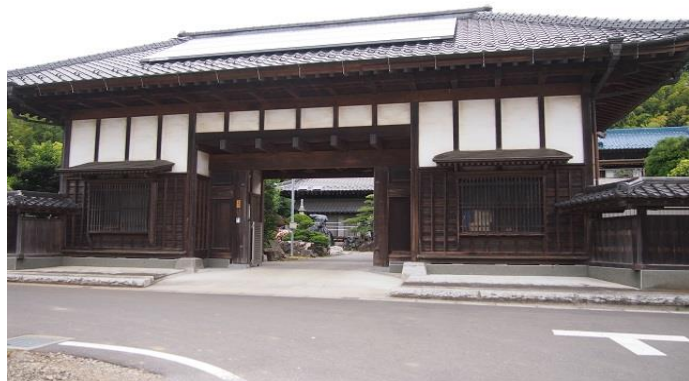
「船橋北部旧小野田村 角頼家長屋門」
