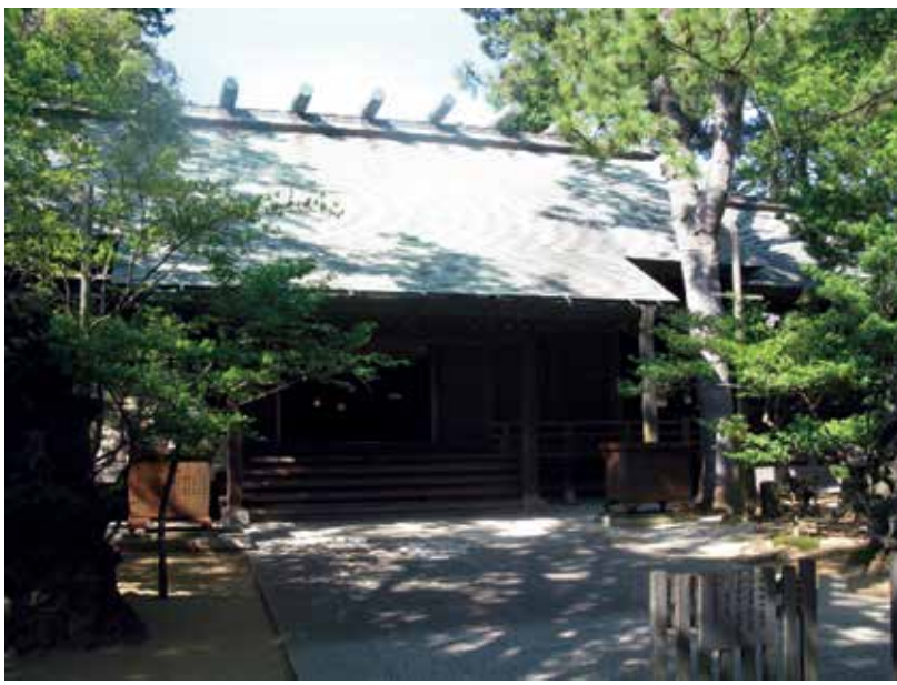
「船橋大神宮・神明造り拝殿、本殿は更に奥にあり」
