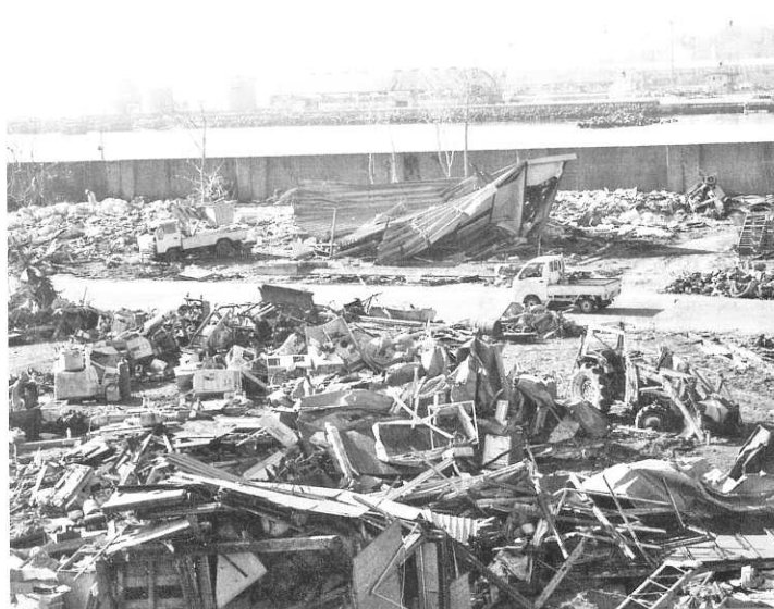
3月11日 宮古市光岸地 この防波堤を越えて来た波で破壊されました
