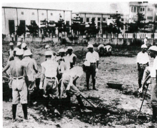
川岸運動場の整地（昭和13年）
