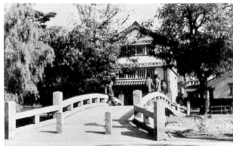
倉敷の土蔵づくり
